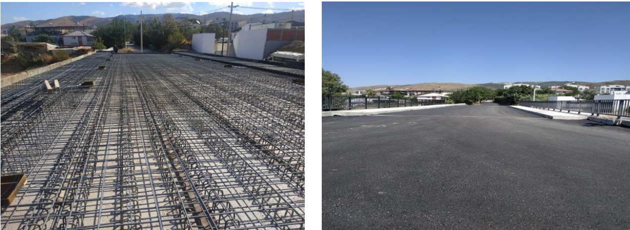
Resim : 2487 Sokak Köprü Yapımı
