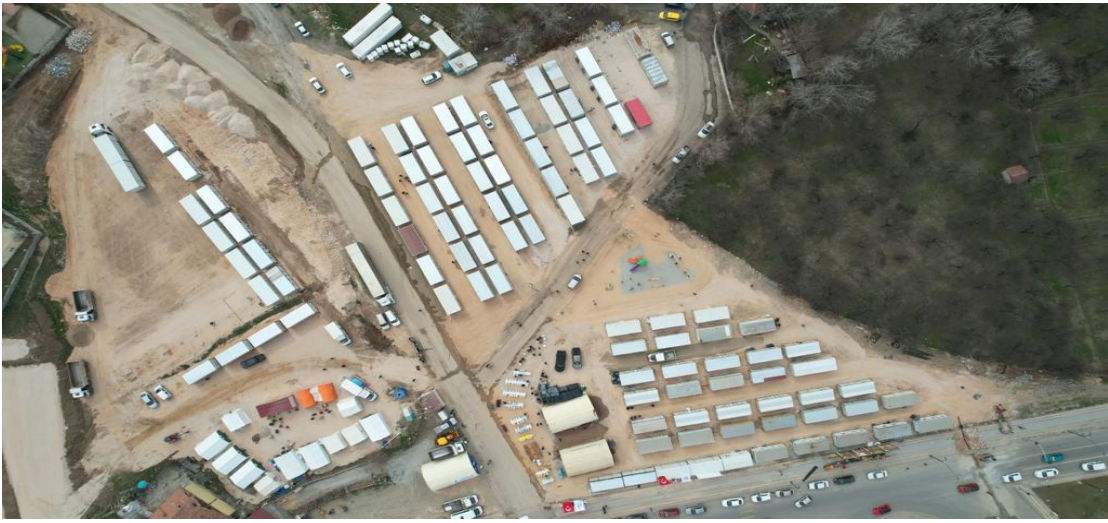
Resim : Depremden etkilenen illerden Malatya İline Yapılan Konteyner Kent
